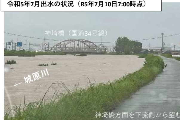
令和5年7月出水の状況 (R5年7月10日7:00時点)
