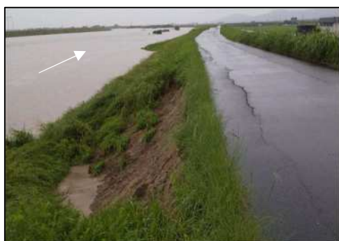
写真 1.2.1 堤防の法崩れの様子
