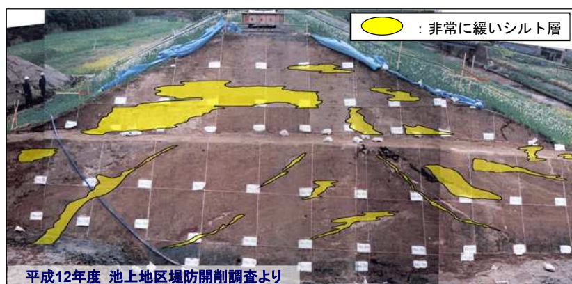
図 2.1.4 堤防開削調査の結果
