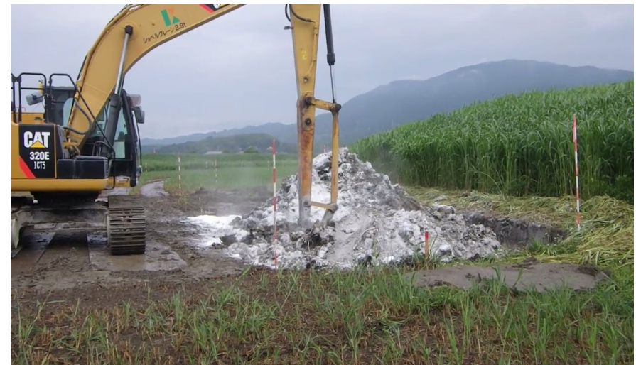
六角川・牛津川での石灰改良の実施状況
