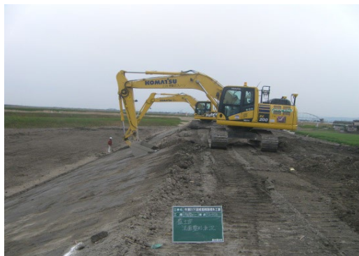
建設発生土の再利用(築堤への有効活用)
