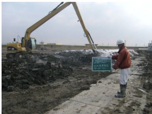
建設発生土の再利用(築堤への有効活用)
