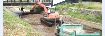
▶河川浚渫・伐採
