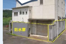
▶排水機場 機能向上
