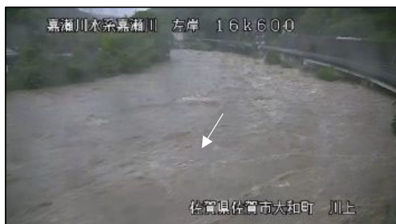
写真 1.2.3 川上水位観測所の状況
