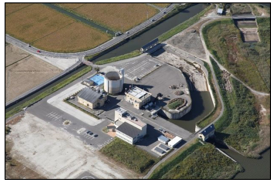
写真 2.1.4 巨勢川ポンプ場
