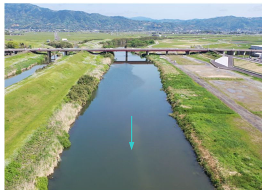
写真 2.3.10 中流部河岸の様子
