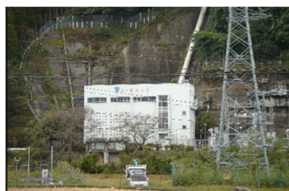
写真 1.3.2 鮎の瀬発電所
