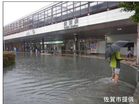
写真 2.1.2 令和元年 8 月洪水（佐賀市）
