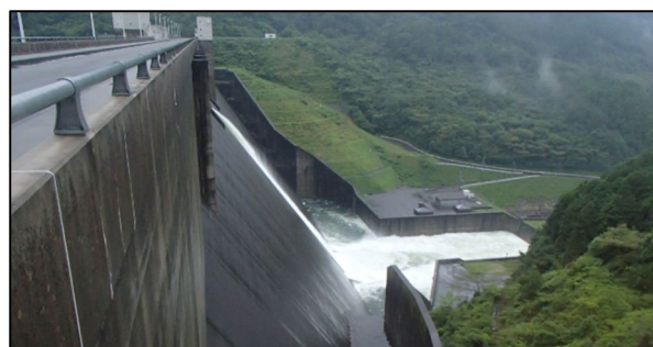
写真 1.2.4 洪水調節中の嘉瀬川ダム
