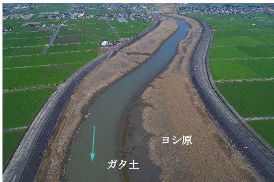
写真 2.1.5 ガタ土の堆積状況（佐賀市）
