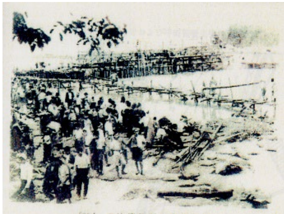
決壊箇所の復旧工事
