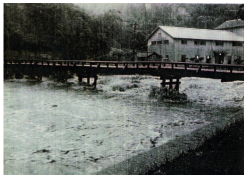
古湯中の橋付近の出水状況
