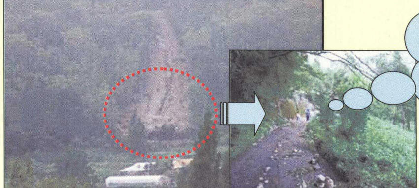
崩壊土砂を擁壁及び防護柵で人家、道路を保全!
