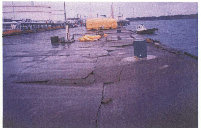
③【大分県大分港鶴崎地区】 波浪・高潮によって、岸壁エプロンが崩壊した。
