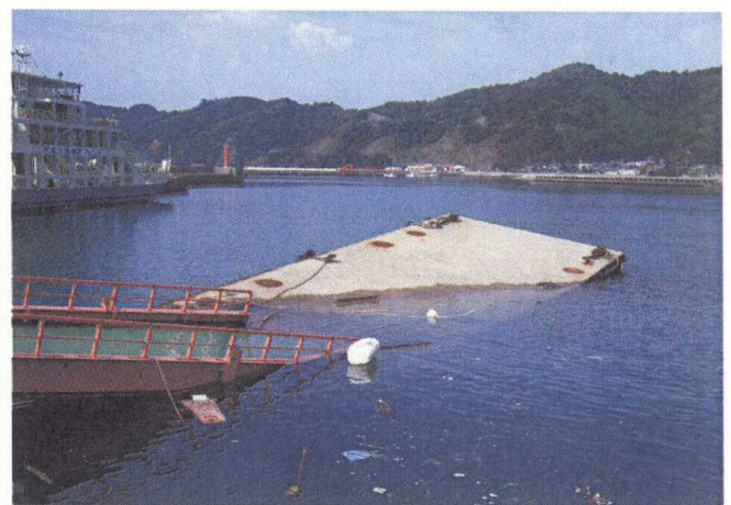
③【熊本県大道港中園地区】 波浪によって、浮棧橋及び渡橋が沈没した。
