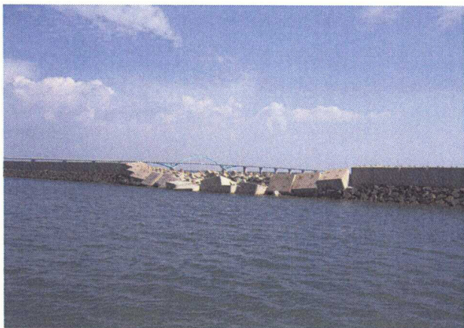
②【福岡県苅田港新松山地区】 波浪によって、護岸防波の方塊が転落した。
