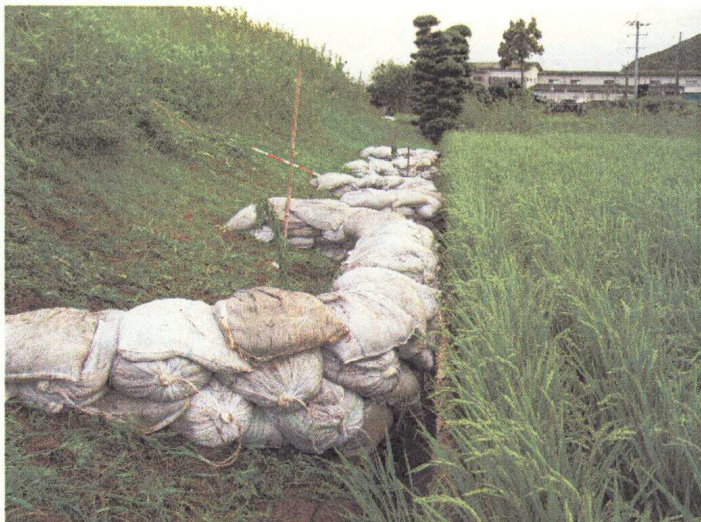
五ヶ瀬川右岸10k000付近 下三輪町地先
