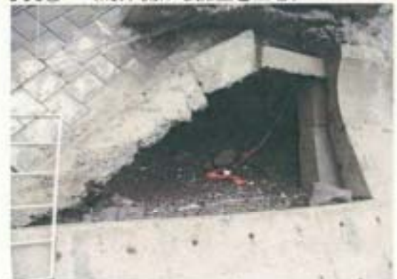
写真② (海岸側から擁壁を望む)
