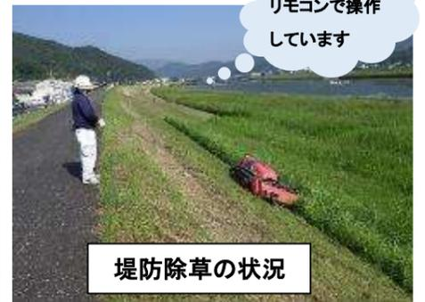
川への不法投棄や水質事故、堤防、護岸、排水ポンプ場、排水門等の河川管理施設の異常などが確認するため、河川巡視、堤防除草や堤防点検などを行っています。堤防除草は、年2回の堤防点検(出水期前点検、台風期前点検)のため、年2回行います。また、巡視、点検にて発見された損傷箇所や危険箇所などの異常について、機能の維持や安全性の確保を図るための補修工事を行っています。
