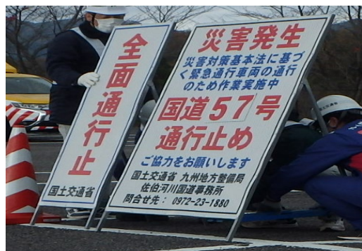
全面通行止め看板設置状況
