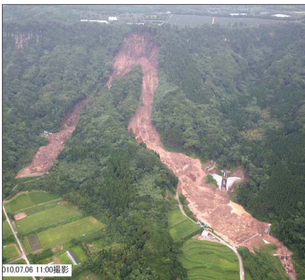
鹿児島県南大隅町根占山本 船石川
