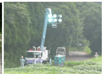
夜間監視用の照明車の設置状況
