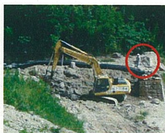
ロボQ(簡易遠隔操縦装置)の作業状況
