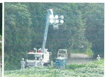
夜間監視用の照明車の設置状況
