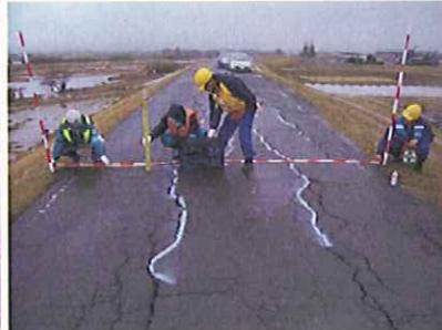
堤防亀裂被災調査状況
