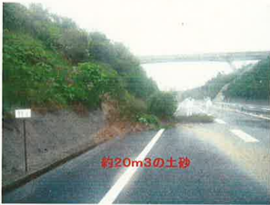
6月12日15:00 法面崩壊発生
