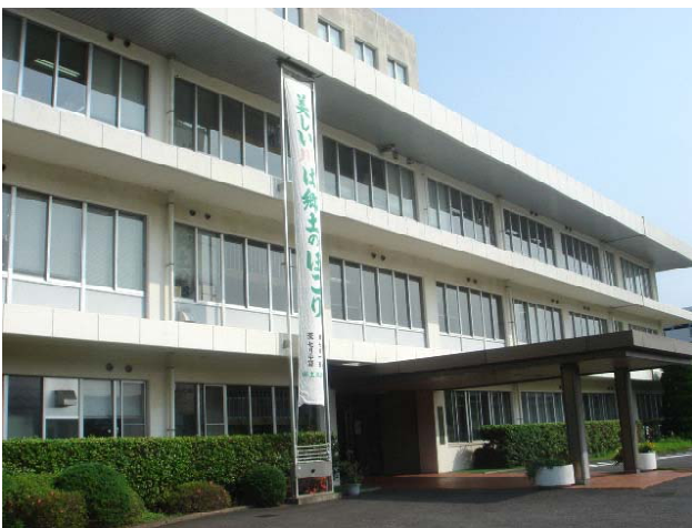
佐伯河川国道事務所庁舎への懸垂幕の設置 （平成22年7月）
