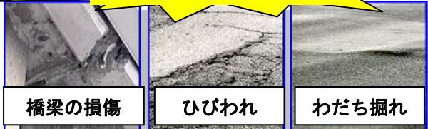
過積載車両による道路損傷
