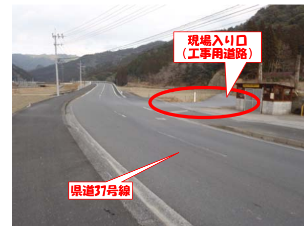
②. 工事用道路出入り口写真 (蒲江側から佐伯側を望む) 赤太線が現場出入り口です。
