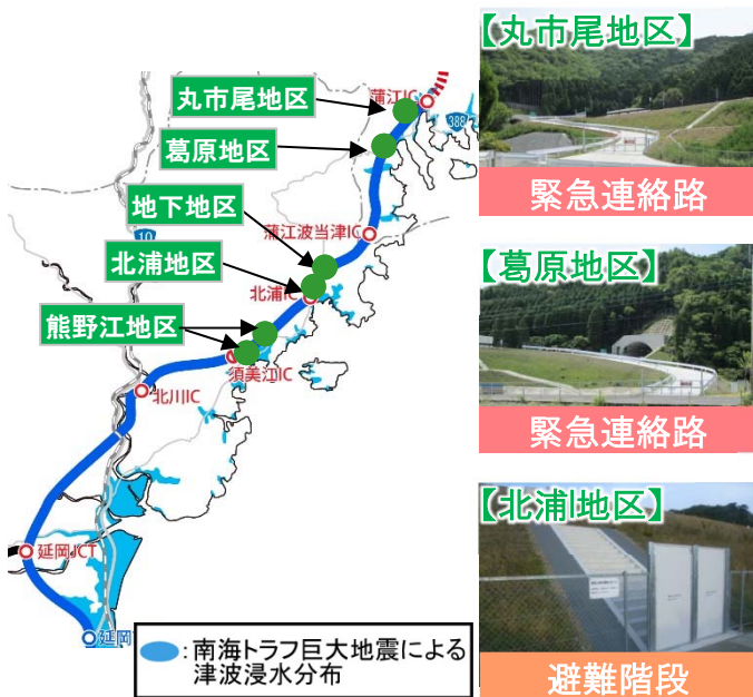
▲避難施設の設置状況(H27.1現在)
