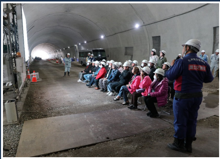
令和8年度中の開通を目指す滝室坂道路の （仮称）滝室坂トンネルも見学して頂きました
