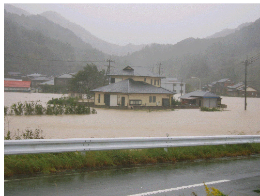
樫野地区内水被害状況
