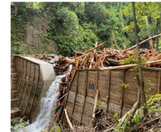
流木捕捉式治山ダムが流木を捕捉した事例【熊本県球磨村】
