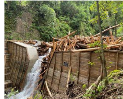
流木捕捉式治山ダムが流木を捕捉した事例【熊本県球磨村】
