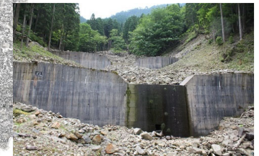
土砂を補足した治山ダム
