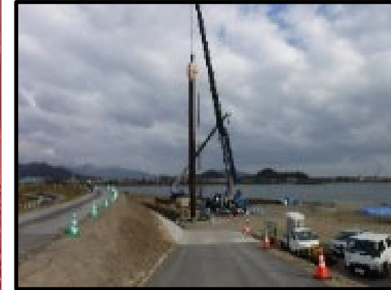
沈下防止のための矢板打設
