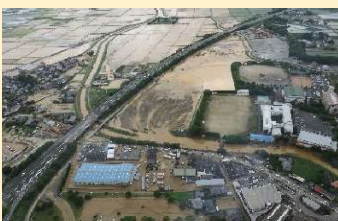
④桂川における浸水被害 (福岡県朝倉市)
