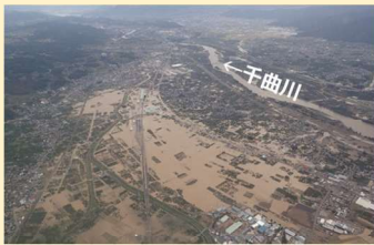
⑧千曲川における浸水被害 (長野県長野市)
