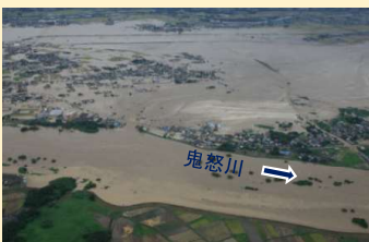
①鬼怒川の堤防決壊による浸水被害 (茨城県常総市)
