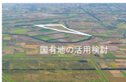
国有地を活用した貯留施設
