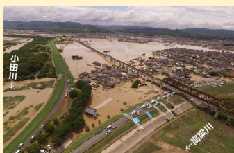
⑤小田川における浸水被害 (岡山県倉敷市)
