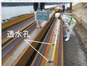
液状化対策工(鋼矢板)
