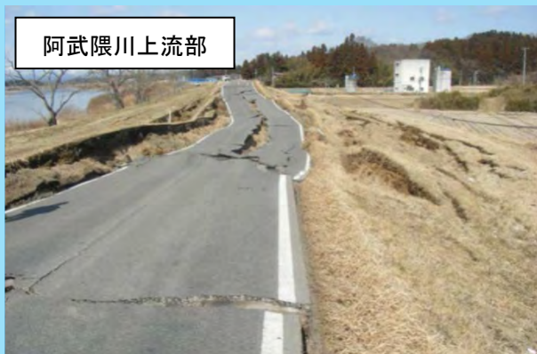
地震による堤防の被災状況
