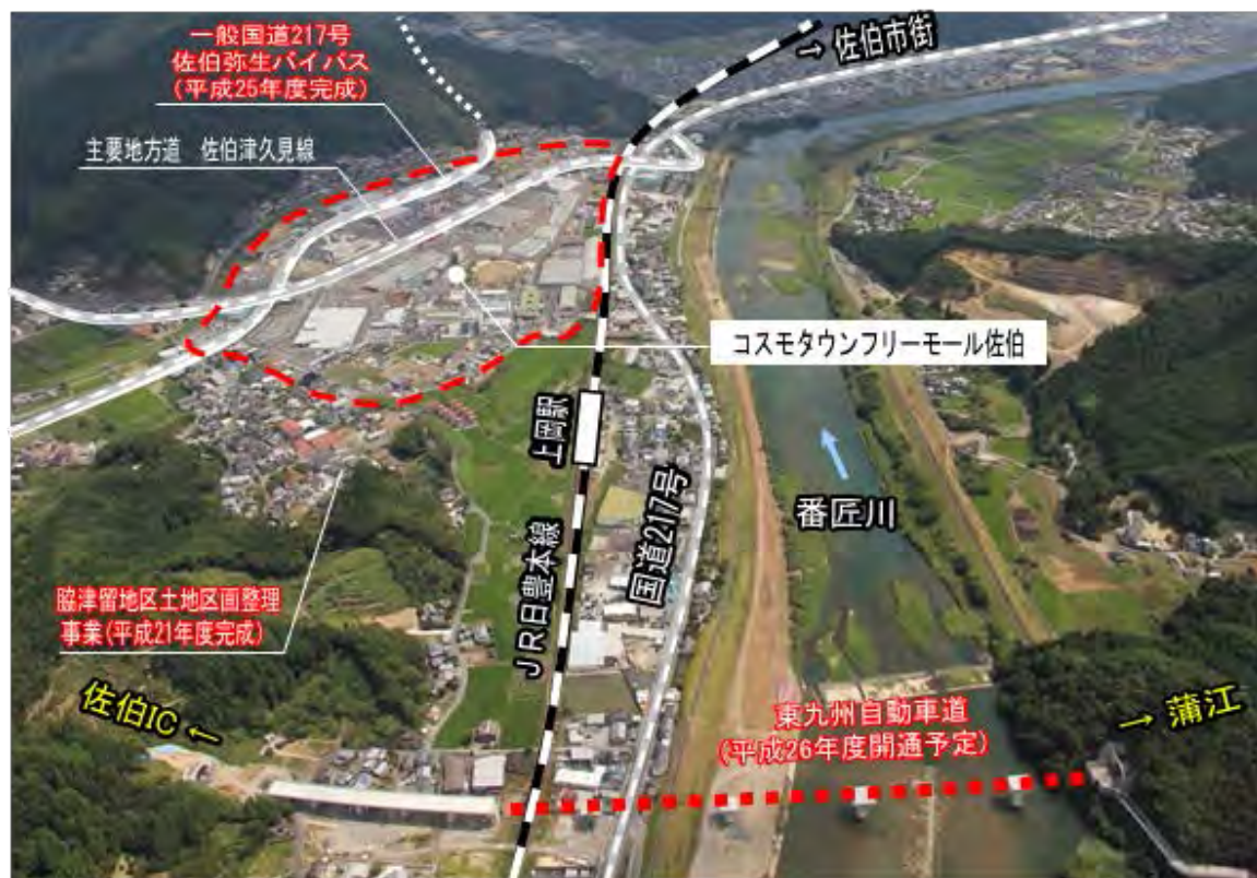
脇津留地区の状況(平成26年撮影)
