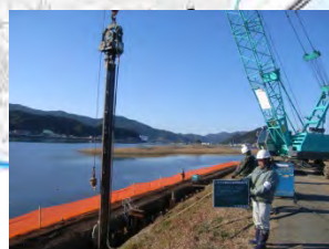
液状化対策工(鋼矢板)
