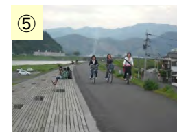
堤防天端の自転車利用
