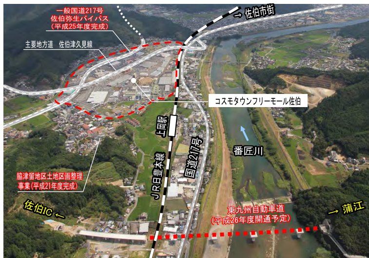
脇津留地区の状況 (平成26年撮影)
