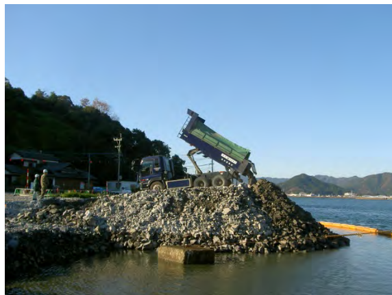
発生土の築堤工事への再利用(番匠川)
