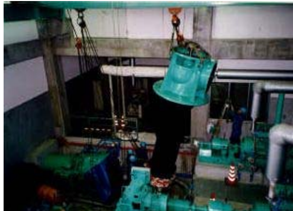
写真 4.3.3 排水ポンプの分解修理（脇排水機場）
