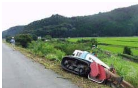
写真 4.3.4 堤防除草状況
