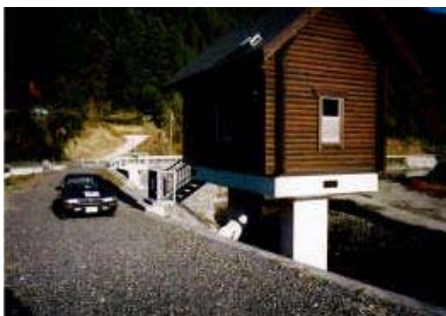
写真 4.3.13 地震時の巡視状況
