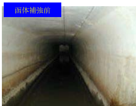
写真 4.3.6 河川管理施設の修繕（笠掛樋門の函体補強）
