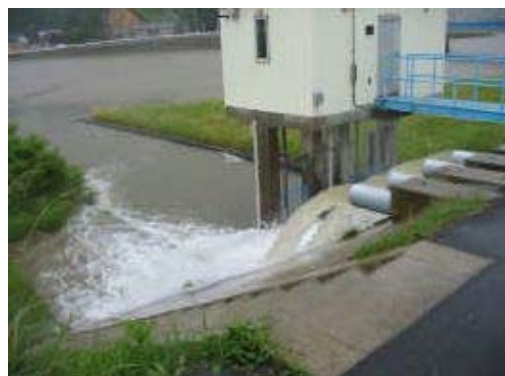
写真 4.3.15 緊急内水対策車による内水排除 (エビセキ樋管)
