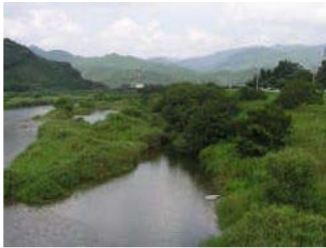
写真 4.3.8 河道内に繁茂した樹木 (番匠川檜野地区)
