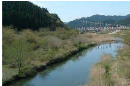
写真 4.3.9 河道内の樹木 (井崎川井崎地区)
