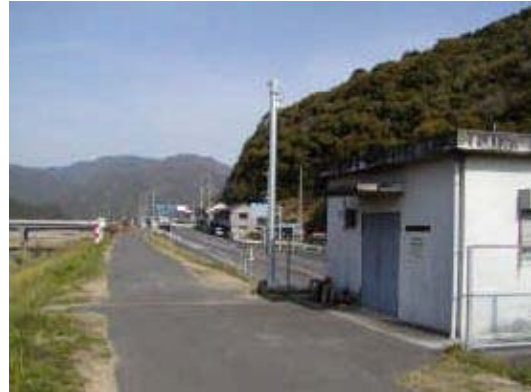
写真 4.3.2 遠隔監視カメラ（番匠橋）
