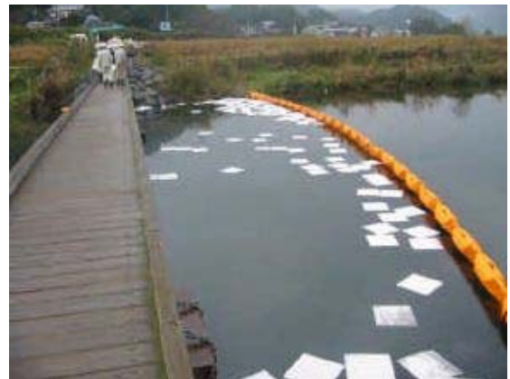
写真 4. 3. 23 水質事故被害の拡散防止（オイルフェンスと吸着マットの設置状況）
