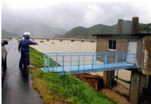
写真 4.3.12 洪水時の巡視状況
