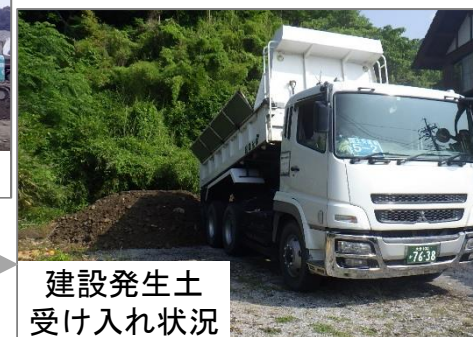
他行政工事へ再利用
