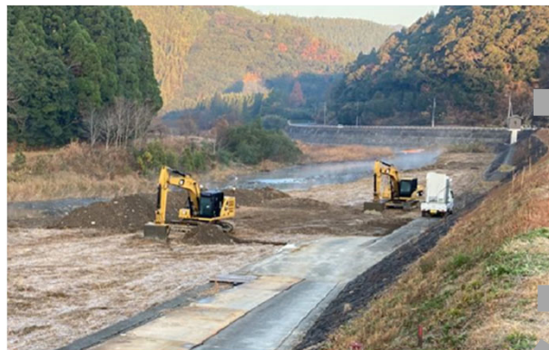
河道掘削事例（久留須川）
