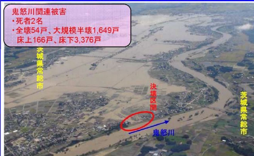
決壊区間航空写真(H27/9/11撮影)
