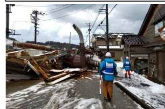
被災状況調査
