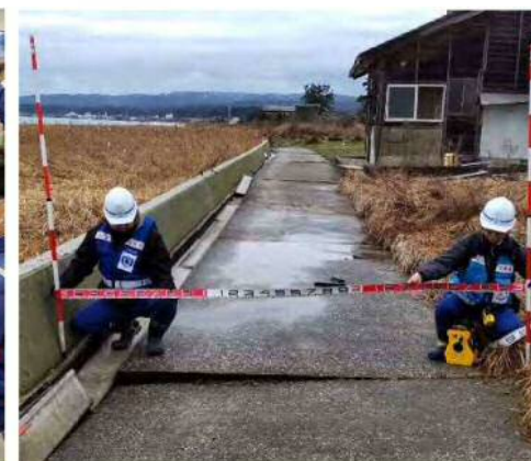
▲海岸護岸調査(珠洲市)
