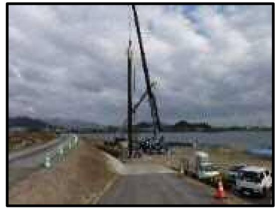
沈下防止のための矢板打設
