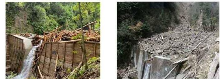
流木捕捉式治山ダムが流木を捕捉した事例【熊本県球磨村】
