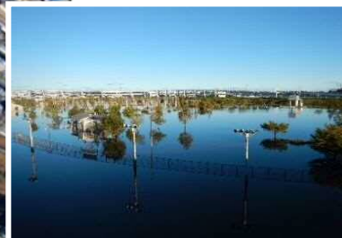
台風第19号時の貯留状況
