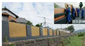
自主防災活動による置堤設置 (楯保川水系、たつの市)
