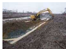
河道掘削 (石狩川水系、北海道開発局)
