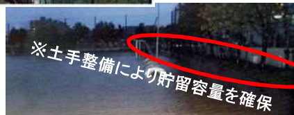
【校庭を活用した貯留施設】
