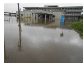
浸水時の状況 (喜多方市提供)
