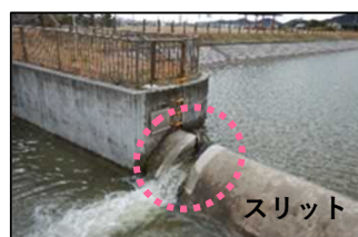
▲スリットの設置状況
