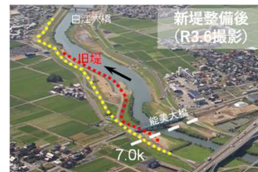
引堤(石川県梯川水系梯川)
