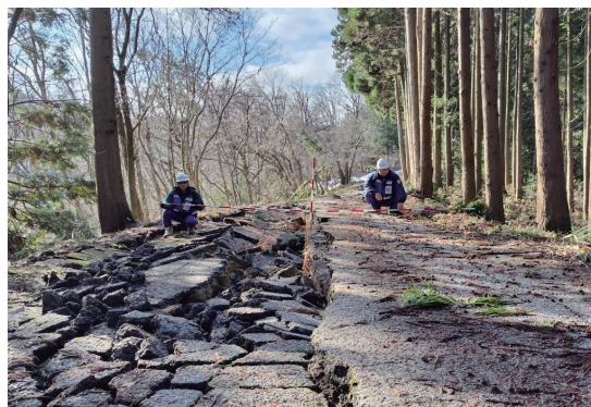
調査状況(石川県輪島市)
