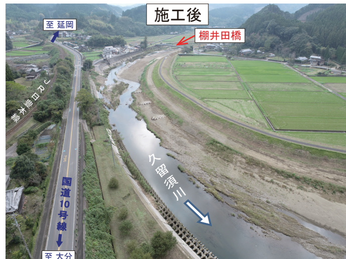
【久留須川棚井田付近の堆積土砂撤去(令和6年度)】
