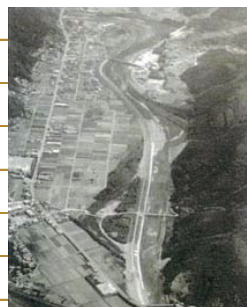
●井崎川捷水路工事／昭和54年度
