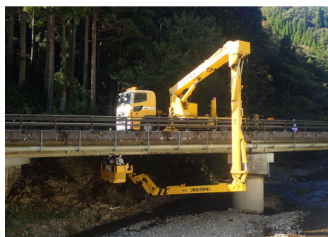
橋梁点検車による点検状況
