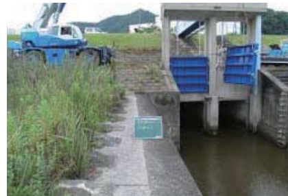
門扉の補修状況
