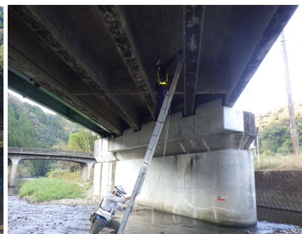
ハシゴによる橋梁点検状況
