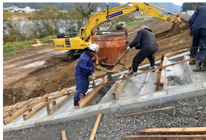
階段の補修状況
