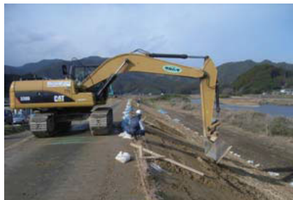
堤防斜面の補修状況
