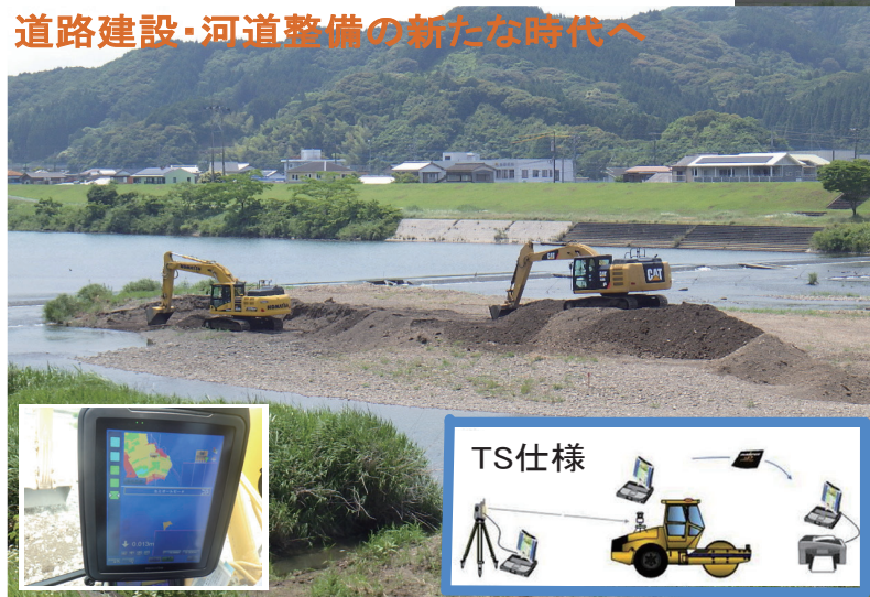
ICT建設機械による施工
