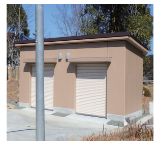
防災用備蓄倉庫
