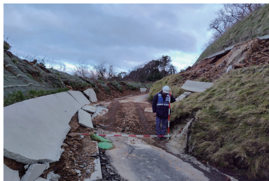
調査状況(石川県輪島市)
