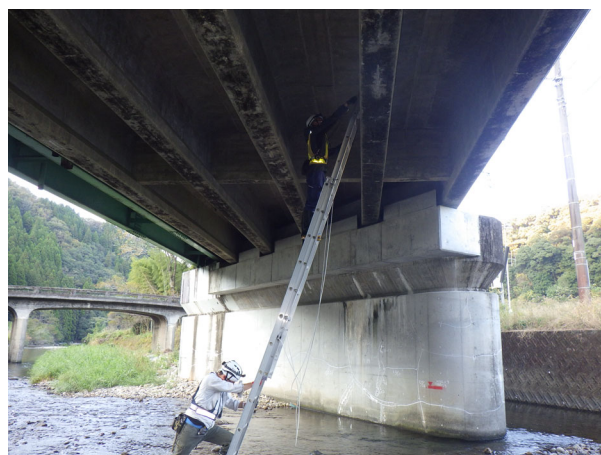
ハシゴによる橋梁点検状況
