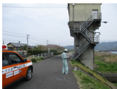
河川巡視の状況
