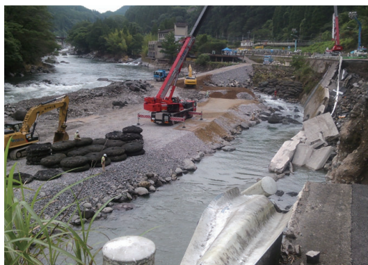
復旧作業の様子(大分県日田市)
