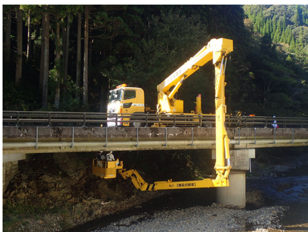
橋梁点検車による点検状況
