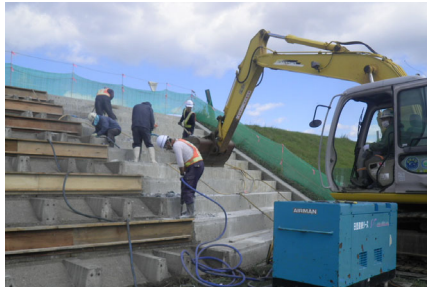
階段の補修状況
