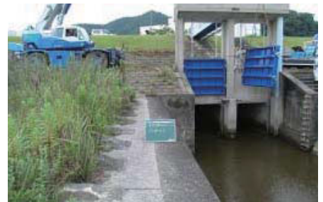
門扉の補修状況
