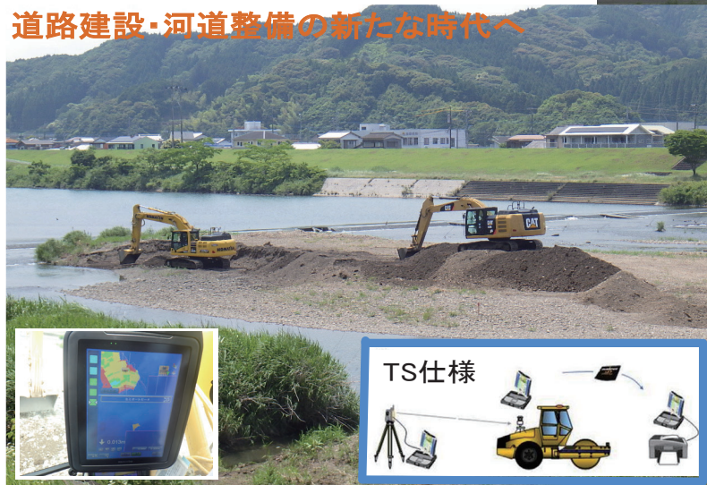
ICT建設機械による施工
