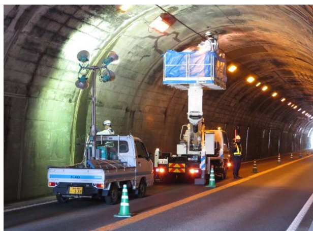
高所作業車によるトンネル点検状況
