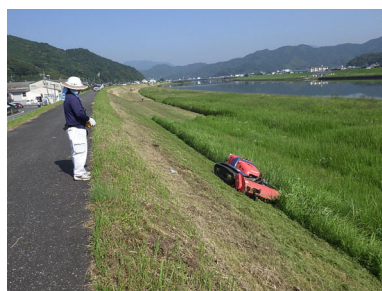
堤防斜面の除草状況
