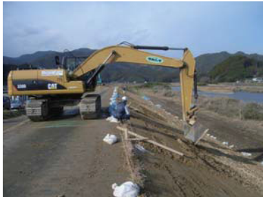
堤防斜面の補修状況
