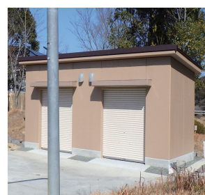
防災用備蓄倉庫
