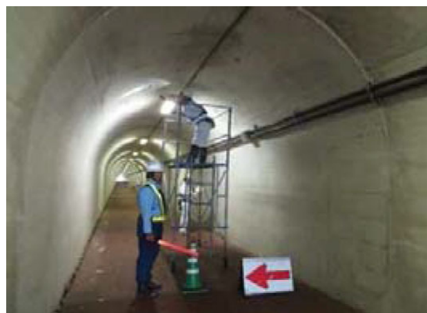
足場を使用したトンネル点検状況
