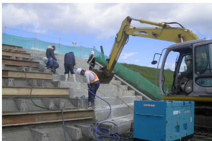
階段の補修状況
