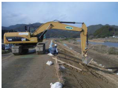
堤防斜面の補修状況
