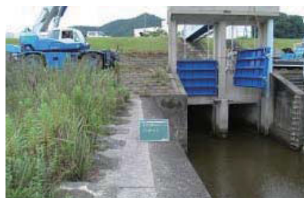
門扉の補修状況
