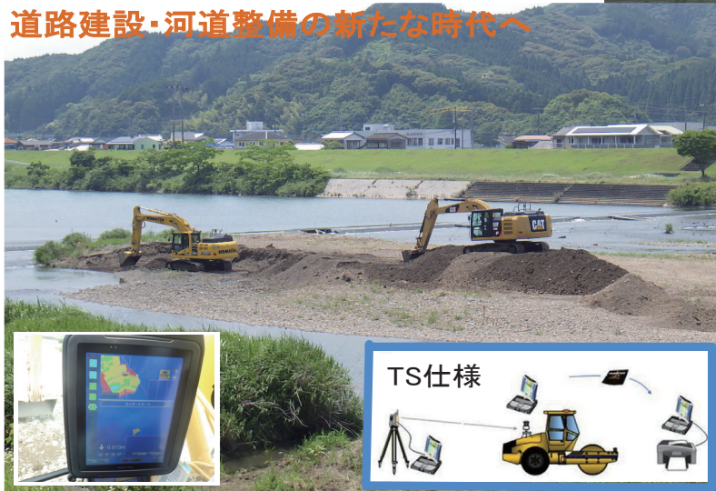
ICT建設機械による施工
