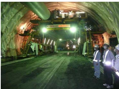
【トンネル内の施工状況を確認】
