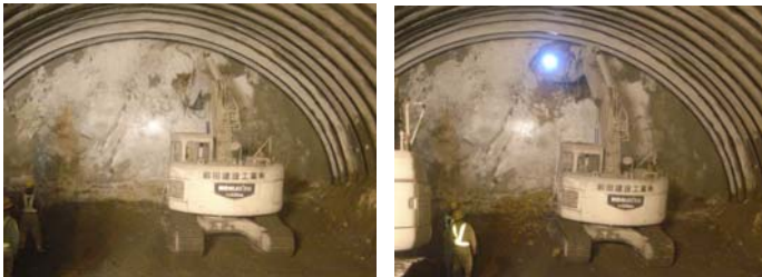
▲大型ブレイカによるトンネル貫通の瞬間
