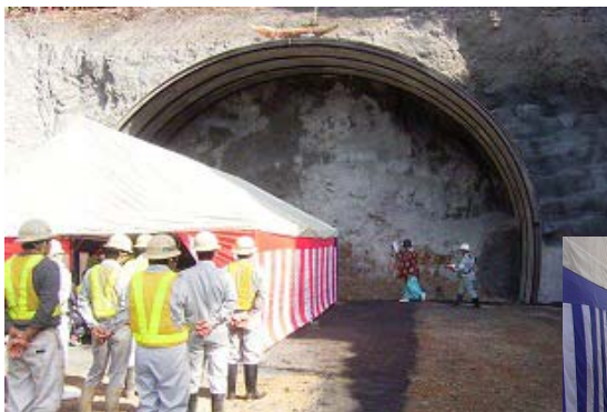
▲森崎トンネル南坑口部
