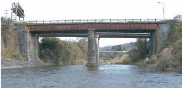
写真 - 1 明治橋の現況
