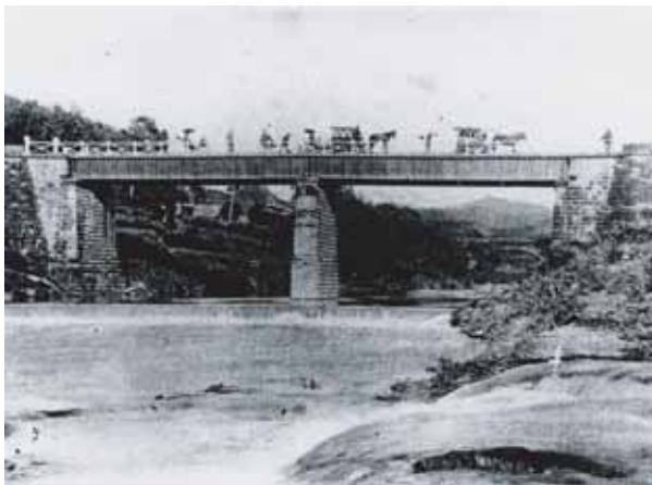
写真 - 2 架設当時の明治橋
