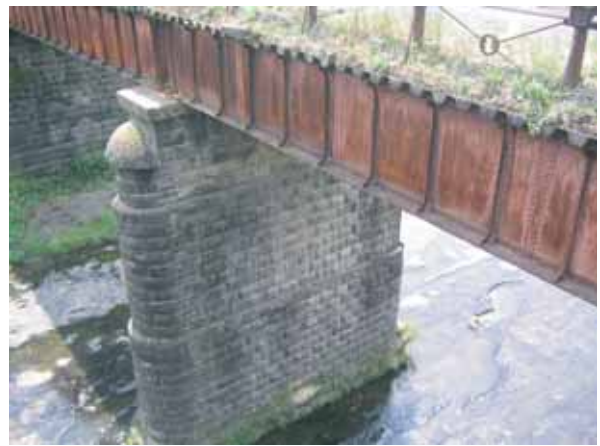
写真 - 3 中間橋脚付近の明治橋
