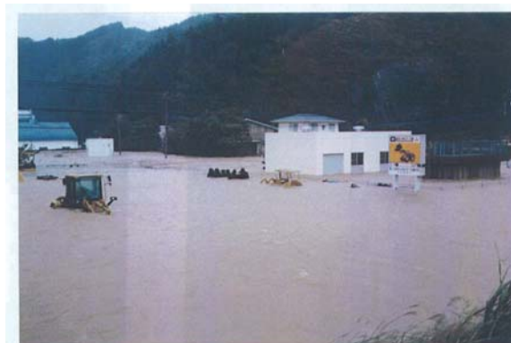
H16年9月台風14号内水状況
