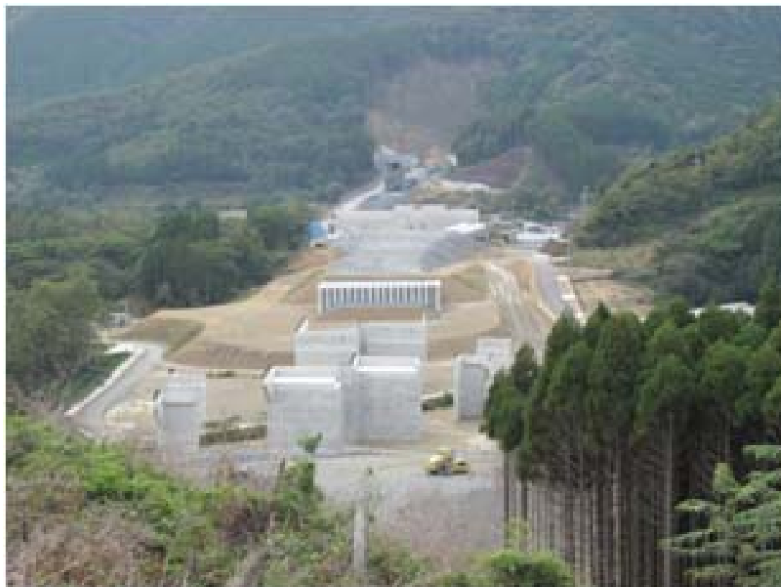
写真：蒲江 I C (仮称) 付近建設現場
