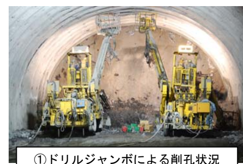
①ドリルジャンボによる削孔状況
