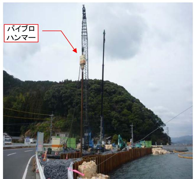
仮設道路を造るためクレーンに吊り下げたパイプロハンマーにより、川の中に綱矢板打ちを行っている様子
