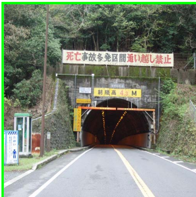
中の谷トンネル全景
