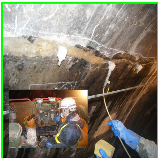
工事実施状況（H21）
