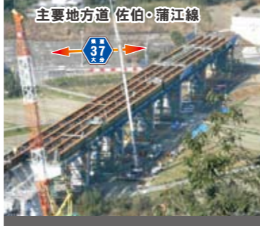
橋桁を設置しています
