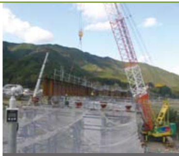
橋桁を設置しています
