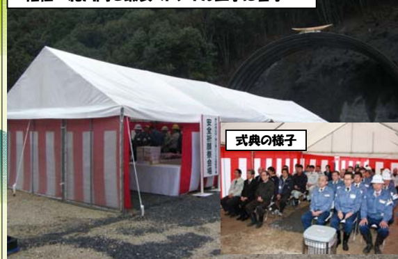
蒲江トンネルの南側で安全祈願祭! 佐伯～北川間で最長のトンネル工事に着手!
