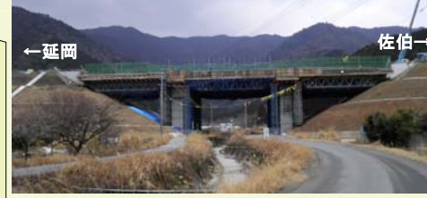
森崎川橋の上部工工事中! H24年7月末に完成予定!
