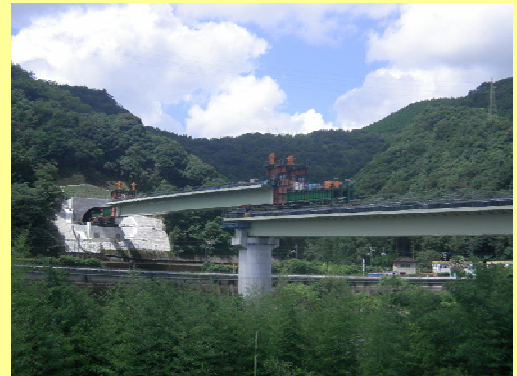
すさ大橋の工事状況
