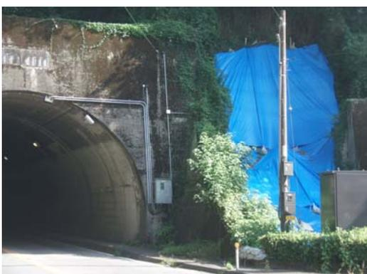
坑口部の小崩落(国道57号三砂トンネル)
