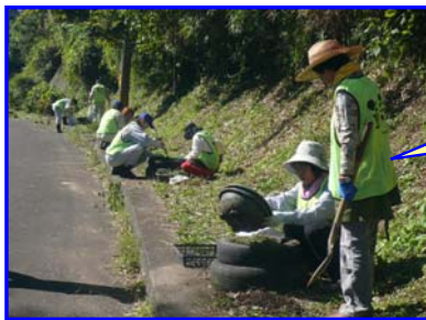
「道守」ユニフォームを着用して作業
